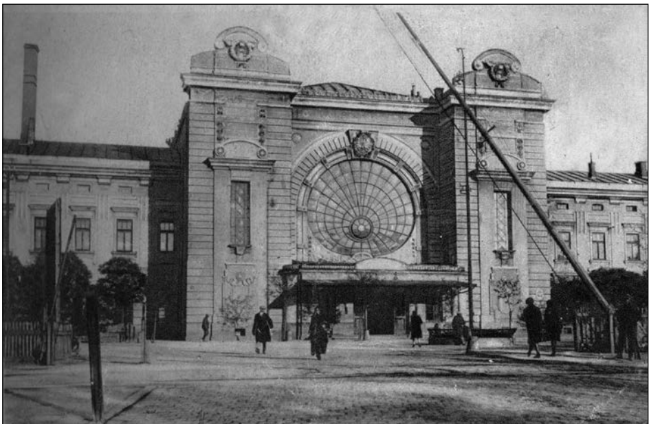
Dworzec kolejowy w Tarnopolu (kartka pocztowa)
