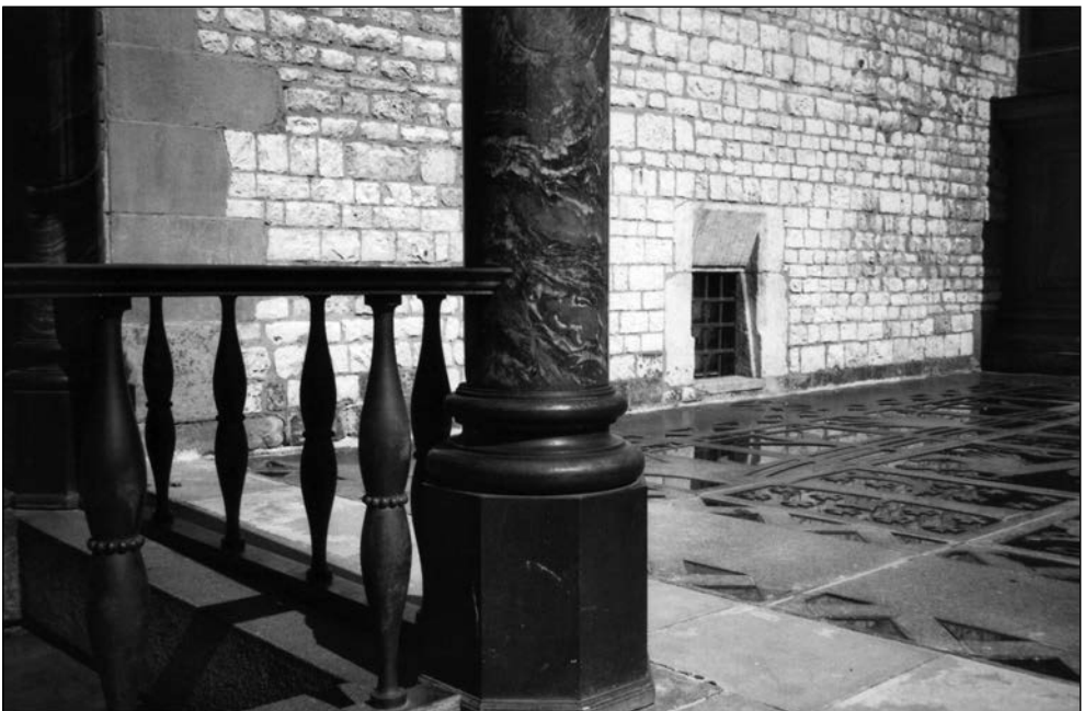
Sześć kolumn nefrytowych wspiera dach baldachimu. Kolumny osadzone w bazach – kwiecień 2009 (fot. G. Gill)
