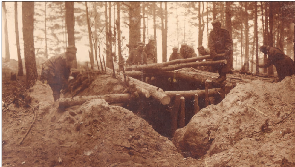
Budowa ziemianki pod Optową na Wołyniu
