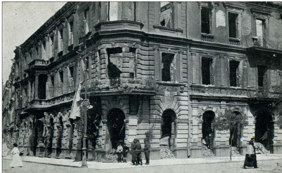
Spalona kamienica przy ul. 3 Maja
