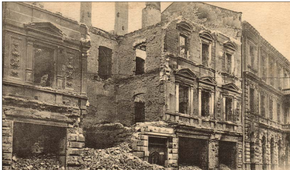
Spalona kamienica w Tarnopolu
