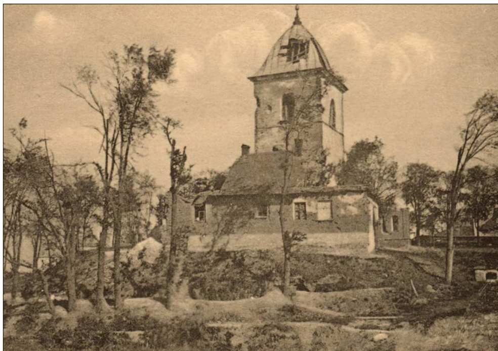
Cerkiew uszkodzona w wyniku ostrzału
